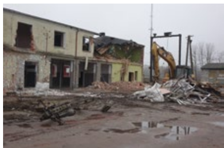
Prace rozbiórkowe przy SKR
