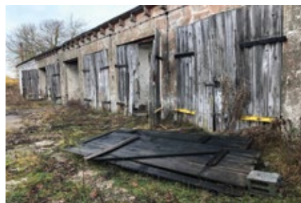
Stan pozostałych budynków SKR-u przed rozbiórką
