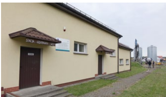
Stacja Uzdatniania Wody – budynek technologiczny
