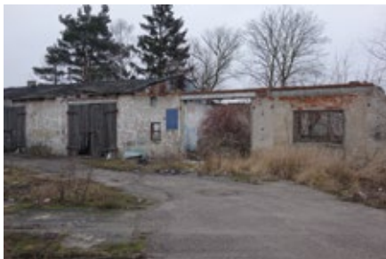
Budynki gospodarcze SKR-u po pożarze
