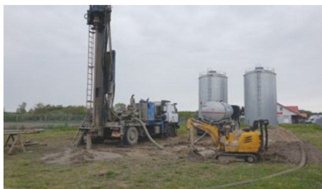
Niebawem w tym miejscu powstanie trzecia studnia głębinowa
